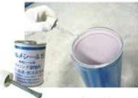
2.1 ทากวอร์เมสทิด 55 ที่หน้าตัดท่อ เพื่อป้องกันสนิมบริเวณหน้าตัดท่อ
