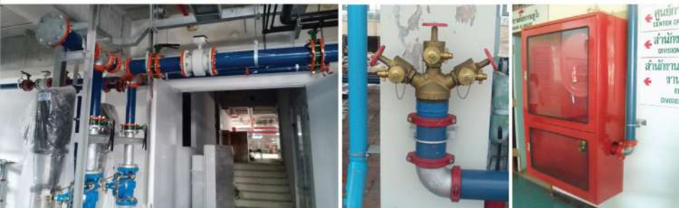
ภาพการติดตั้ง PRV กับท่อ SYLER
