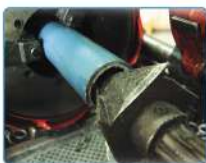
การแต่งปลายท่อด้วยเครื่องตัด
