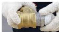
5. ขันข้อต่อหนีปเปิดเข้ากับวาล์วประตูน้ำ หรือ GATE VALVE โดยไม่ต้องรอให้กาเวอร์เมสซีล 55 แห้ง
