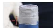
11. ทาบริเวณผิวท่อให้เกลี้ยงมาจากเกลียว ประมาณ 1 ซม.
