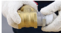
5. ขันข้อต่อบีบเข้ากับวาล์วประตูน้ำ หรือ GATE VALVE โดยไม่ต้องรอให้เออร์เมสซิล 55 แห้ง
