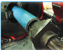
การแต่งปลายท่อด้วยเครื่องตัดปาด
