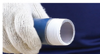
9. พันเทปพันเกลียว หรือสายสัญญาณ บริเวณที่ทำการเกลียวของท่อ
