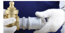
7. ขันข้อต่อตรงเข้ากับข้อต่อนิปลีน โดยไม่ต้องรอให้เฮอร์เมสิล 55 แห้ง
