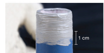
11. ทาบริเวณผิวท่อให้เลอะมาจากเกลียว ประมาณ 1 ซม.
