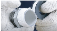
2. ฟันเกบฟันเกลียว หรือสายสัญญาณ บริเวณที่ทาเกลียวของข้อต่อให้ครบทุกเกลียว
